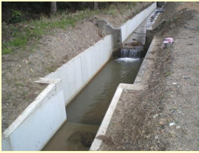
勝山北部地区 (施工直後)
