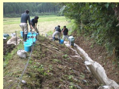
避難水路への移設
