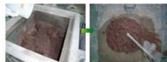
練混ぜ状況 スランプ(10%)
