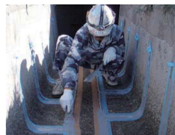
シーリング材充填工
