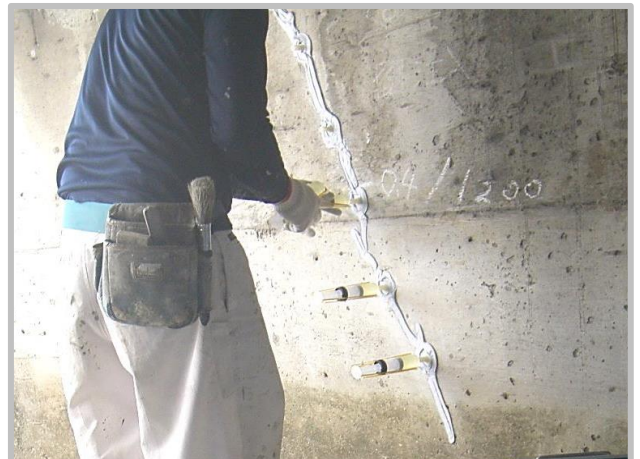
エポキシ樹脂注入工
