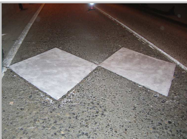
施工完了(薄層補修工法)
