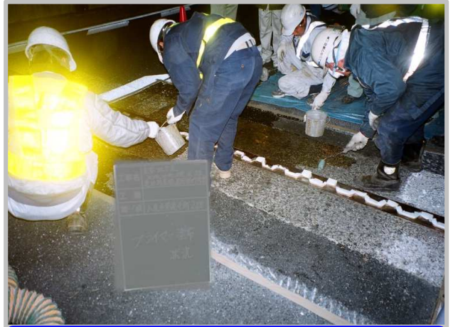
プライマー塗布工
