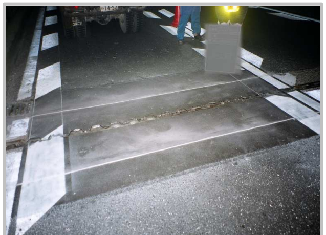
施工完了(橋梁伸縮装置嵩上げ工法)
