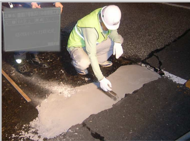
MMA樹脂モルタル打設
