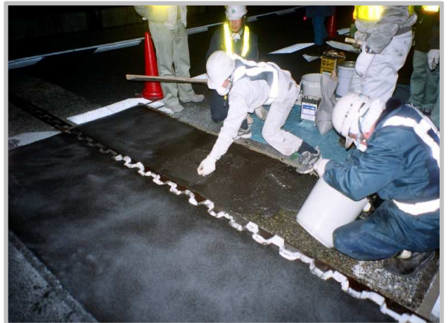
MMA樹脂モルタル打設
