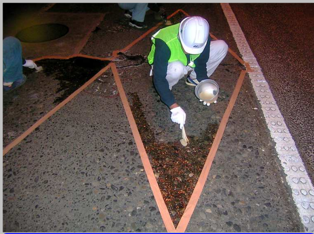
プライマー塗布工
