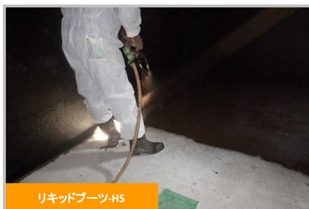
内面防水:防水材塗布工 (エポキシ系)
