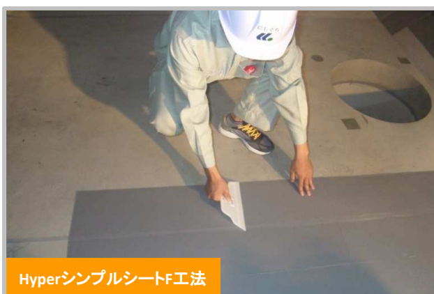
内面防水:防水材塗布工
