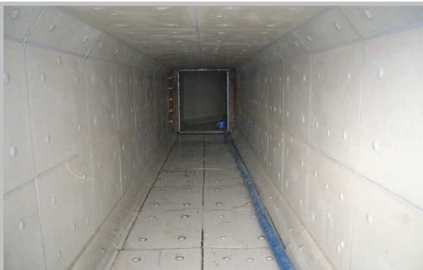
下水処理施設補修
