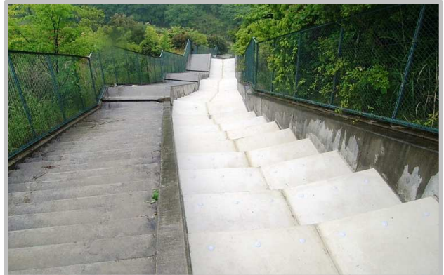
水路落差部補修
