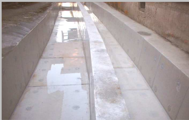
農業水利施設補修
