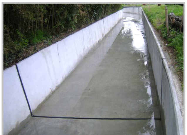
施工完了 (ASモルタル工法との併用)
